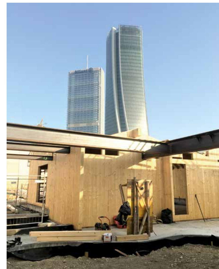
Struttura in X-Lam. Sopra, l'X-Lam e il pacchetto isolante della parete
