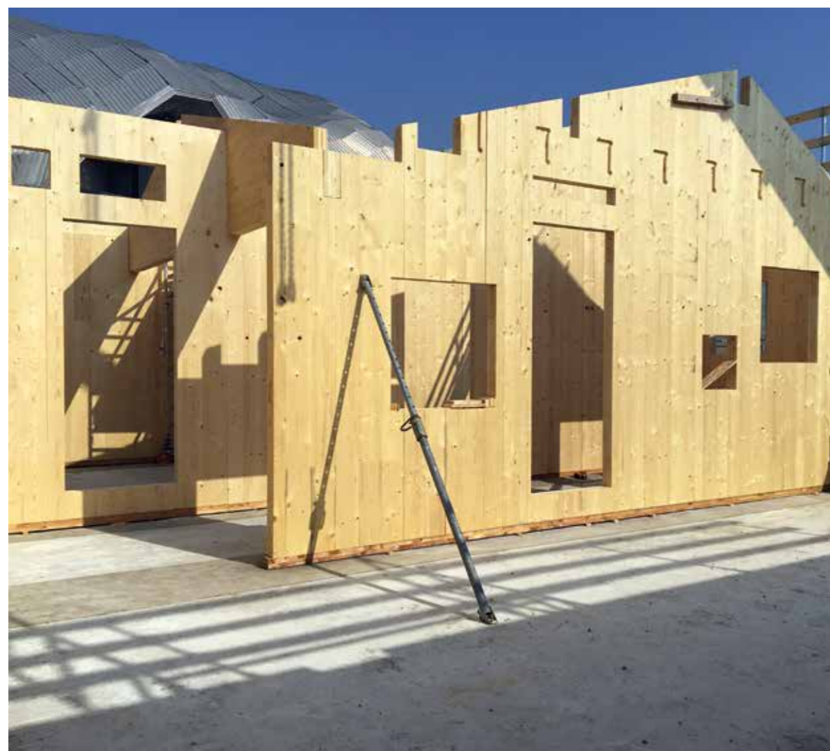
Montaggio dei pannelli in X-Lam. Sotto, stratigrafia dell'involucro edilizio in cantiere
