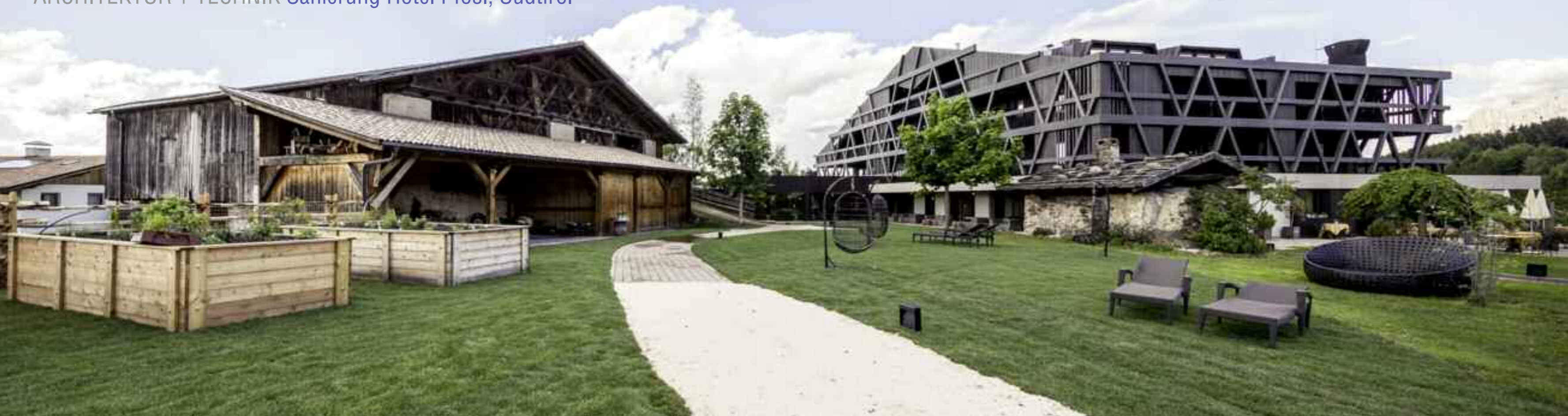
Nukleus für die Neugestaltung der Sanierungsmaßnahme ist der alte denkmalgeschützte Bauernstadel. Er steht dem Baubestand direkt gegenüber.
