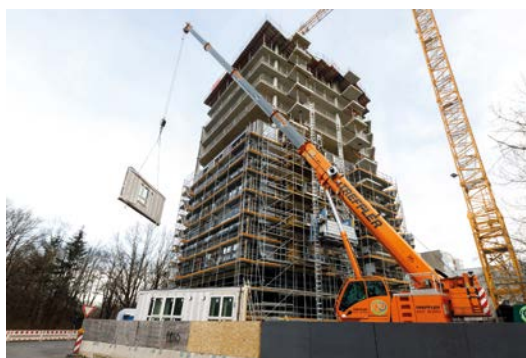
Speciali dispositivi di sollevamento e una gru a torre hanno consentito l'assemblaggio di tutti i pannelli di facciata in legno prefabbricati. Nella parte bassa, le pareti prefabbricate sono state installate con l'ausilio di una gru mobile.
