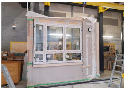
Elemento d'angolo e l'installazione delle finestre in laboratorio.
