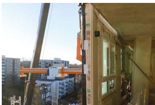
Arrivo e fissaggio di un elemento di facciata. Per poter inserire gli elementi sotto i balconi è stato utilizzato uno speciale dispositivo di sollevamento.
