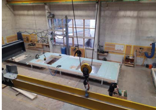
Assemblaggio del telaio in legno in azienda e placcaggio con cartongesso.
