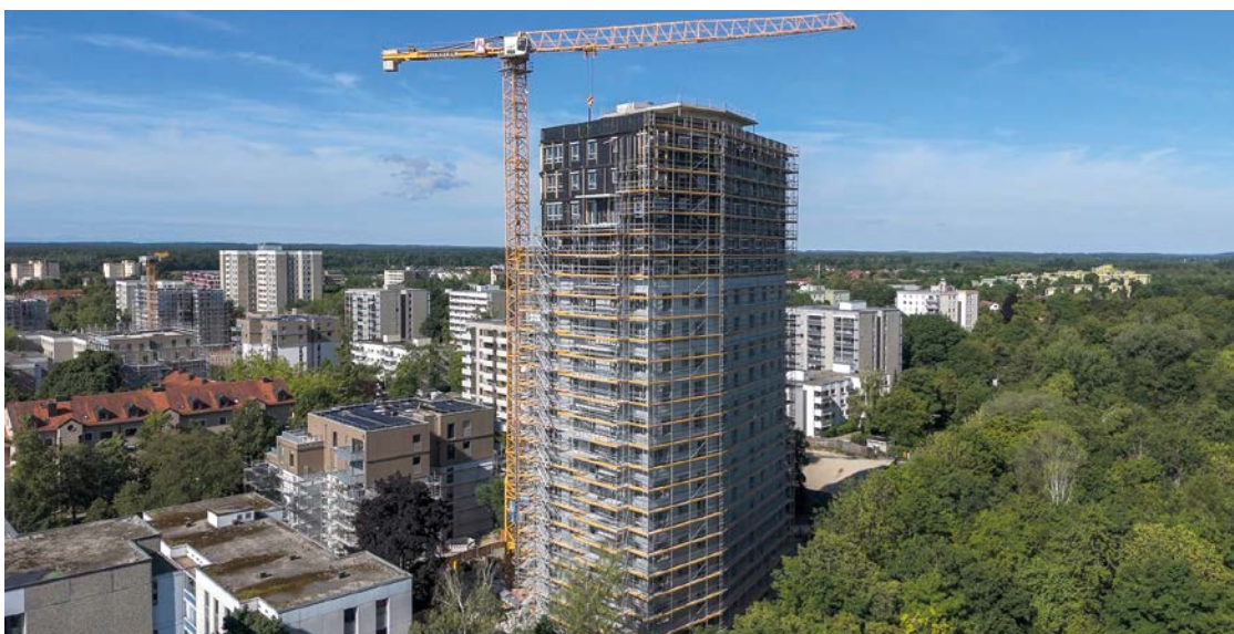
Vista complessiva dell'edificio in costruzione.
