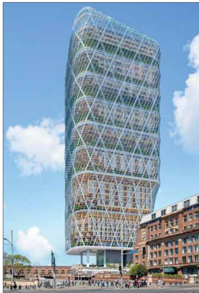
Oben: Die Dachgeometrie der 105 m freispannenden Holzkonstruktion des neuen PNE Amphitheatre in Vancouver resultiert aus drei sich verscheidenden halbzylindrischen Flächen. Links: Visualisierung des 183 m hohen Atlassian Central Tower in Sydney. Zwischen den als Megafloor bezeichneten Stahlbeton-Geschossdecken im Abstand von vier Geschossen sind die Holz-Geschosse eingestellt. Fotos: Atlassian PR/SHoP Architects, Revery Architecture
