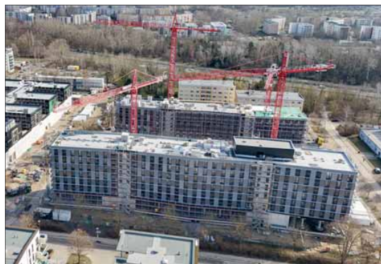
Beim neuen Campus der Zollhochschule in Rostock kombinierten die Architekten Stahlbeton und Holz. Letzteres in Form von 1100 vorgefertigten Raummodulen in Holzbauweise. Foto: Kaufmann Bausysteme
