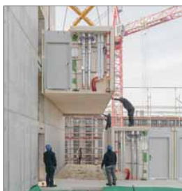
Links: Fassade des Wohngebäudes mit einer wechselnden Holzverschalung. Rechts: Jedes Modul wurde im Werk vollständig vorgefertigt und ausgebaut – was eine schnelle Montage ermöglicht. Fotos: Jan Bitter
