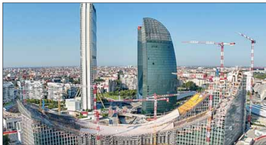
Links: Das Areal von City Life mit dem gleichnamigen Bau Feld. Rechts: Für das Hängedach zwischen den zwei Baukörpern kam Brettsperrholz zum Einsatz. Die doppelt gekrümmte Dachform erhielt unter anderem Spannkabel innerhalb des Holzquerschnitts. Sie wurden in der Aufsicht geradlinig verlegt. Fotos: HB engineering
