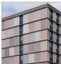
Links: Fassade des Wohngebäudes mit einer wechselnden Holzverschalung. Rechts: Jedes Modul wurde im Werk vollständig vorgefertigt und ausgebaut – was eine schnelle Montage ermöglicht. Fotos: Jan Bitter
