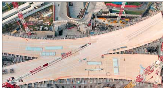
Links: Das Areal von City Life mit dem gleichnamigen Bau Feld. Rechts: Für das Hängedach zwischen den zwei Baukörpern kam Brettsperrholz zum Einsatz. Die doppelt gekrümmte Dachform erhielt unter anderem Spannkabel innerhalb des Holzquerschnitts. Sie wurden in der Aufsicht geradlinig verlegt. Fotos: HB engineering
