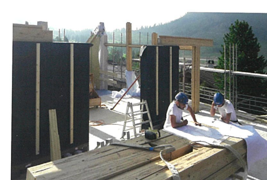
Posa della struttura intelaiata prefabbricata in legno e della scala interna, anch'essa in legno. La complessa struttura della copertura con orditura primaria e secondaria e perlinatura verso l'interno, la chiusura del pacchetto isolante e il rivestimento esterno del tetto.
