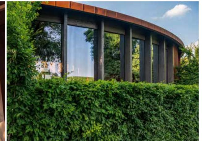
Il tetto circolare in legno è interamente rivestito da una copertura a doppia falda asimmetrica con colmo ventilato, dalla caratteristica forma a Y rovesciata. Il disegno delle due falde concentriche è ritmato dalle numerose lastre profilate a forma trapezoidale, realizzate da Mazzonetto in acciaio Cor-Ten®. La posa in opera con il sistema The Skin Aggraffato è stata lasciata naturalmente esposta agli agenti atmosferici, ossidandosi e stabilizzandosi in circa un anno dal suo completamento.
