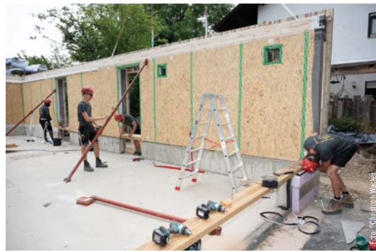
Posa delle pareti esterne prefabbricate con struttura a telaio su cordolo rialzato in c.a.
